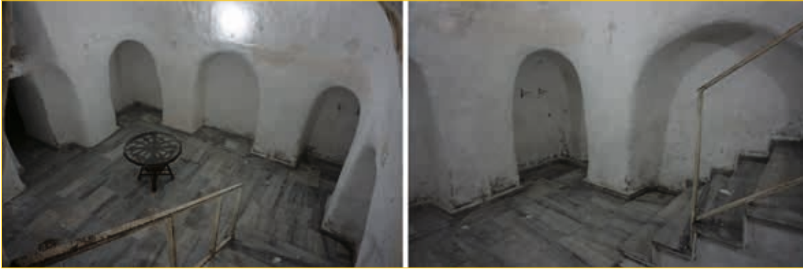
Görsel 60. 14 nolu yeraltı yapısının güncel durumu (İBB KMKM arşivi, 2022)
