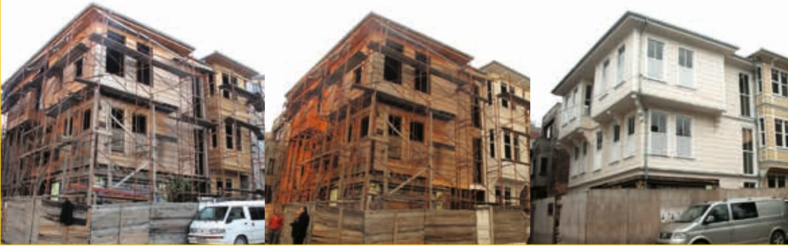
Görsel 5. Kırazlı Mescit Sokağı üzerinde, özgün yapım teknikleriyle onarılan ve günümüzde Alan Başkanlığı'nca kullanılan ahşap konağın onarım süreci (Url-5)
