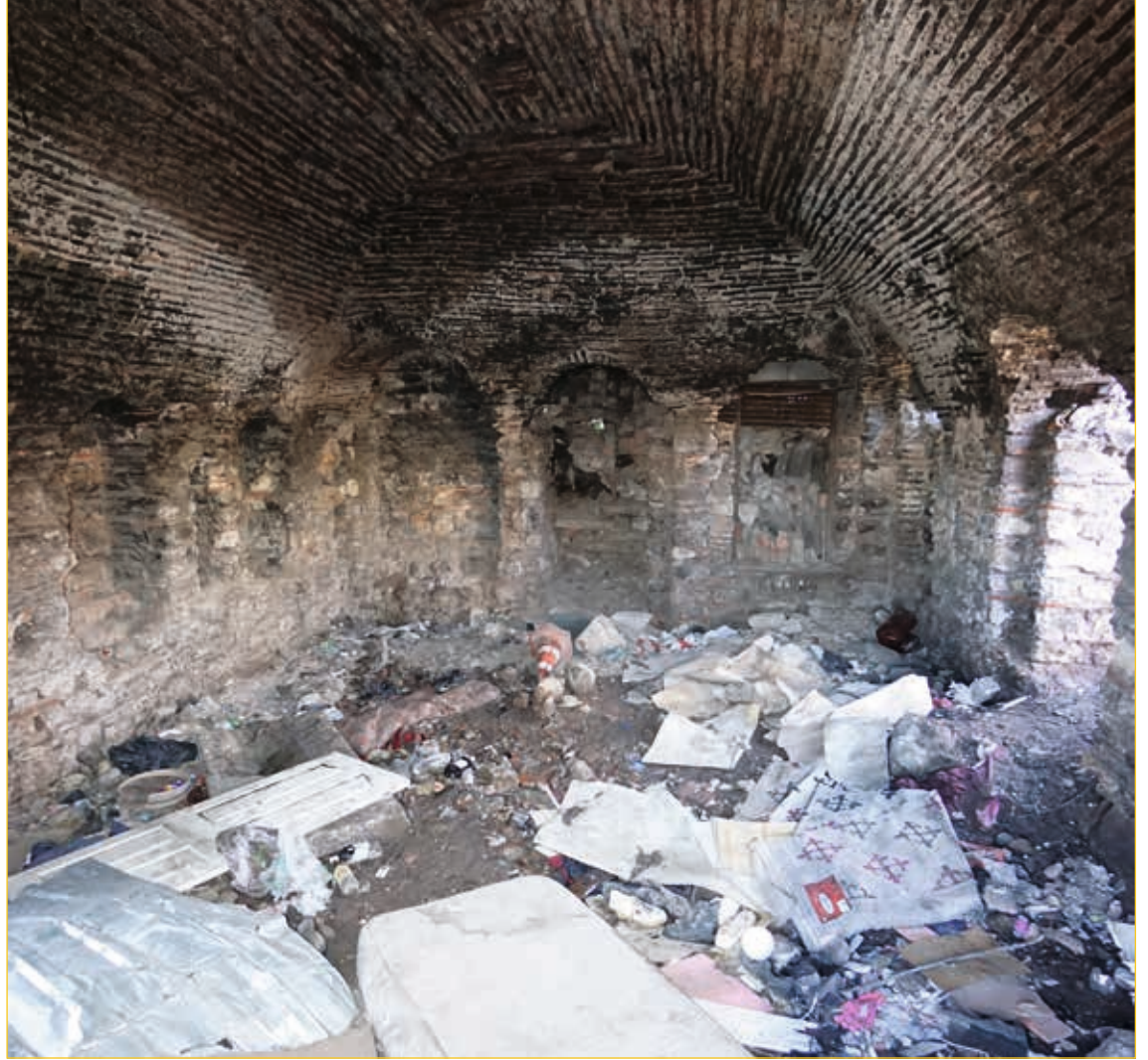
Görsel 56. 3 nolu yeraltı yapısının güncel durumu (İBB KMKM arşivi, 2022)
