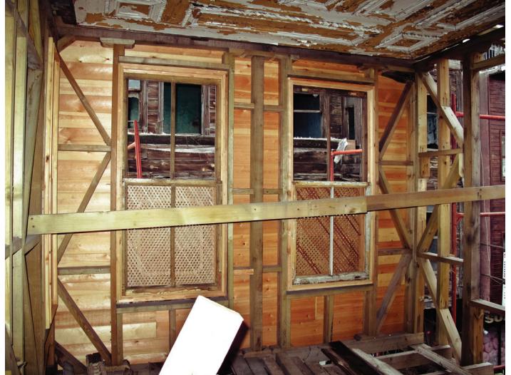
Resim 10. Cephe kaplama levhalarının içeriden görünümü
