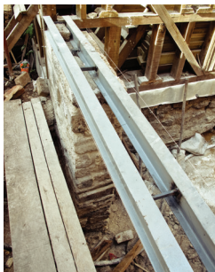
Resim 15. Sökülen demir putrellerin yerine kirişlerin yerleştirilmesi
