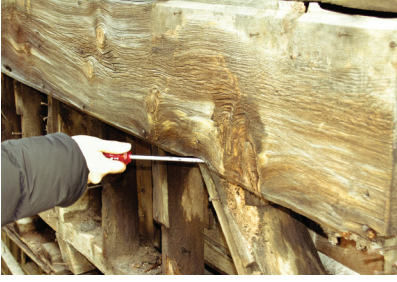
Resim 8. Cephe kaplama elemanlarının onarım öncesi durumları
