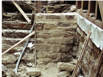
Resim 14. Kaba yonu taş duvarın örülmesi
