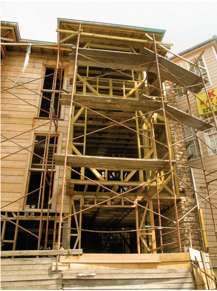
Resim 35. II.Dönem eki ahşap yapıda cephe uygulamasının aşamaları
