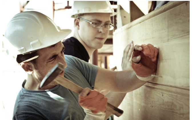
Resim 31. Cephe kaplama levhalarının hazırlanması
