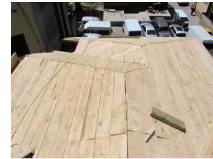
Resim 27. Kiremit altı kaplama tabakalarının uygulanması
