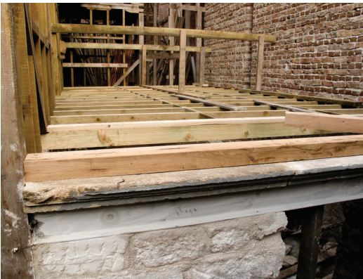
Resim 19. Karkas sistemin üzerine oturtulduğu meşe taban kirişi
