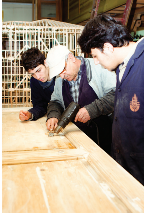
Resim 2. Ahşap yüzeylerindeki boya sökümü işlemleri
