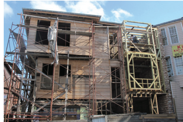
Resim 20. Karkas sistemin yapımı
