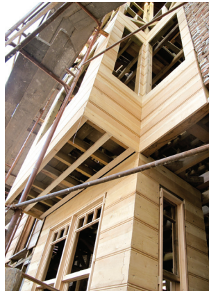
Resim 32. Cephe kaplama levhalarının montajı
