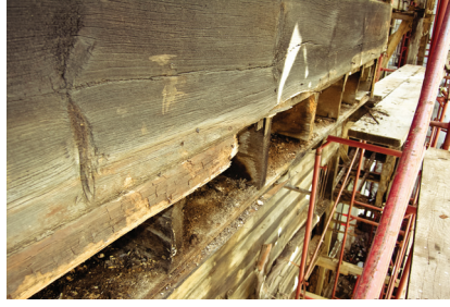
Resim 8. Cephe kaplama elemanlarının onarım öncesi durumları
