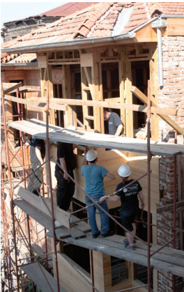
Resim 32. Cephe kaplama levhalarının montajı
