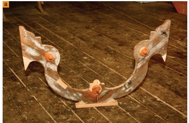
Resim 2. Ahşap yüzeylerindeki boya sökümü işlemleri
