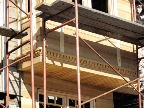
Resim 34. Kat silmelerinin uygulanması
