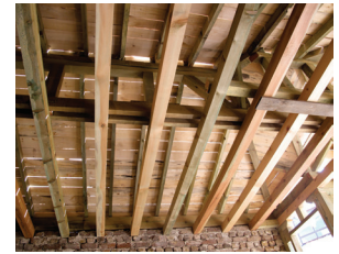
Resim 27. Kiremit altı kaplama tabakalarının uygulanması
