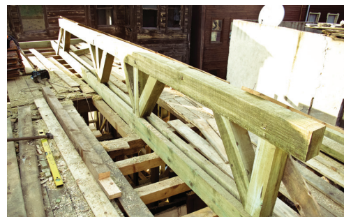
Resim 25. Çatı konstrüksiyo- nunun yapımı
