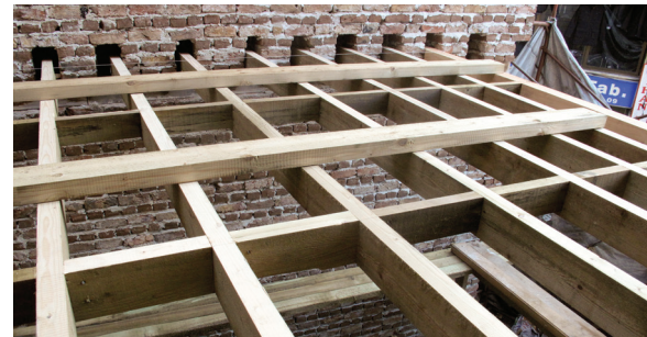
Resim 21. Döşeme kirişlerinin yerleştirilmesi
