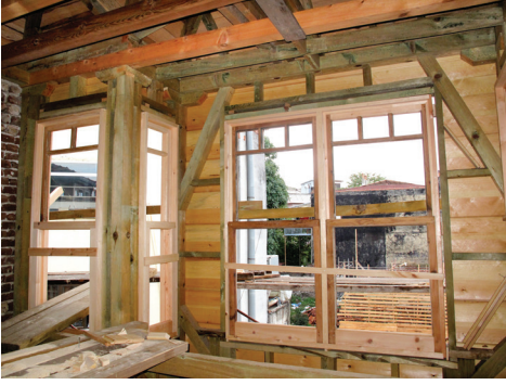
Resim 33. Pencere ve pervazların montajı
