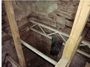
Resim 13. Dükkan olarak kullanılan zemin kattaki eklerin kaldırılması
