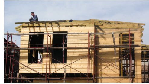
Resim 26. Çatı iskeletinin yapım aşamaları
