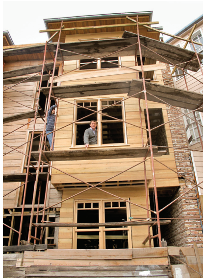
Resim 35. II.Dönem eki ahşap yapıda cephe uygulamasının aşamaları
