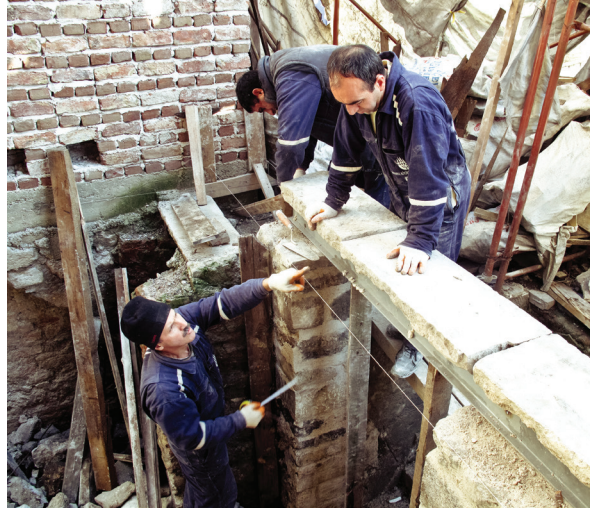
Resim 17. Özgün taş silmenin tekrar yerine yerleştirilmesi
