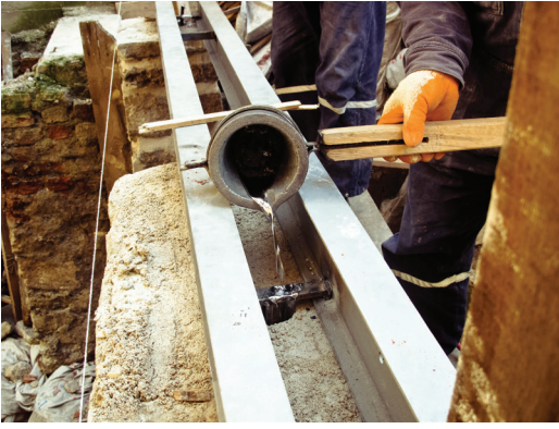
Resim 16. Bağlantı yuvalarının kurşun ile doldurulması
