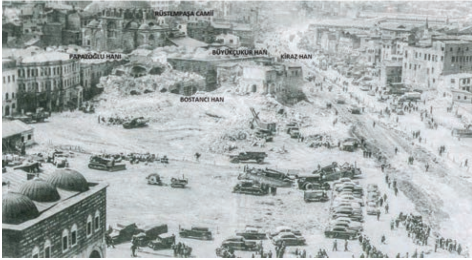
Ragıp Gümüşpala Caddesi ile Eminönü Meydanı'nın açılması esnasında Rüstem Paşa Camisi'nin çaprazı ve Papazoğlu (Kızıl) Han önünde yer alan, revak ve odaları görülebilen Bostancı Han'ın yıkımı.
