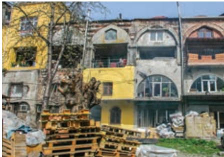
Balkapanı Hanı'nın (16. yy) birinci avlusunun kuzeydoğu cephesinde bulunan ara katlar
