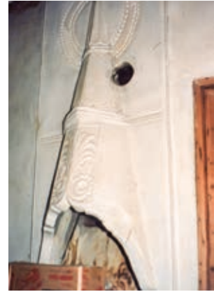
Odaların alçı yaşmaklarına “soba devrinde” açılan boru delikleri
