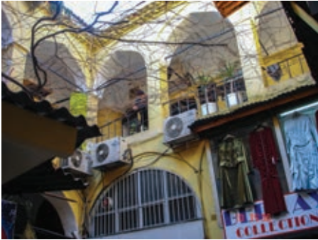
Kaşıkçı Han'da (18. yy) revakların kapatılması ve eklenen ısıtma-soğutma cihazları
