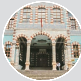
Eski Hükümet Konağı
